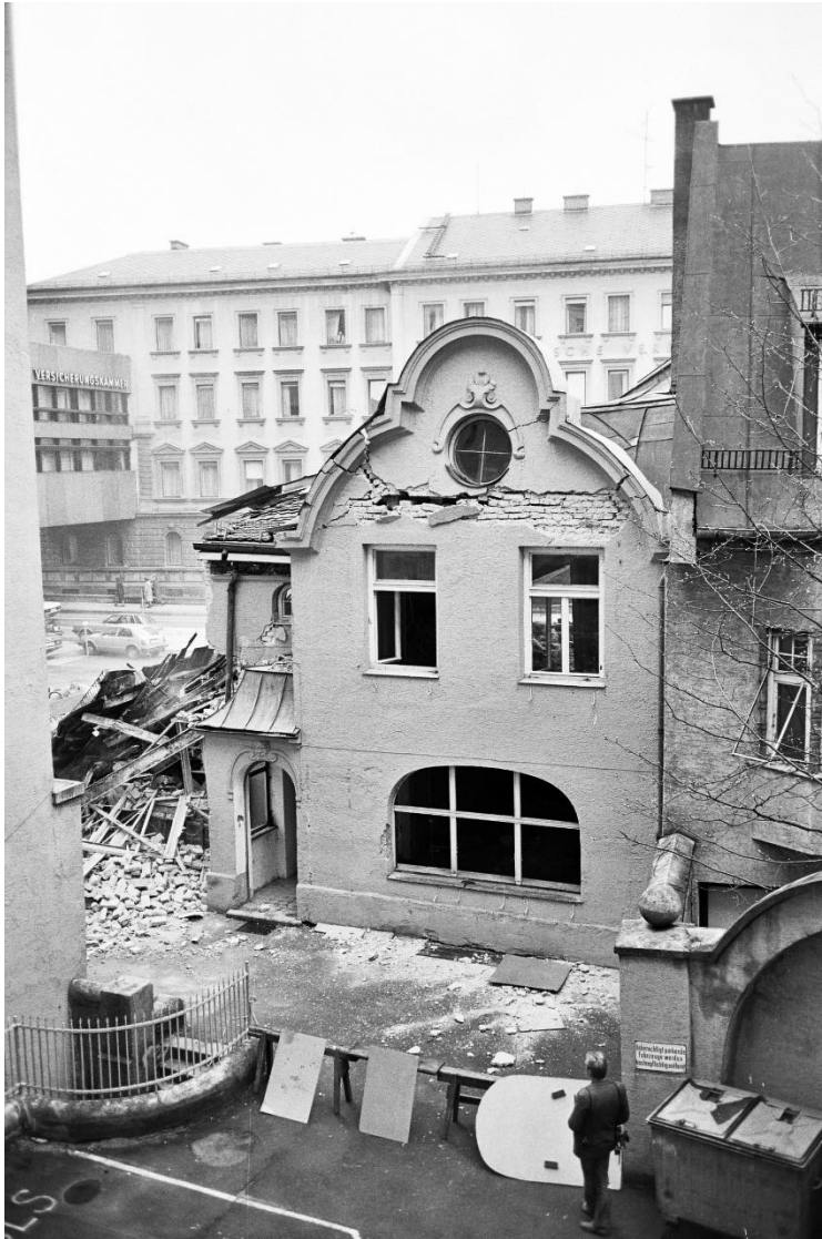
Quelle: Versicherungskammer Bayern (1985), Abbruch der Innenhofbebauung nach Schimmelbefall (Werkstatt des Meister Eder in der Kinderserie Pumuckl)
