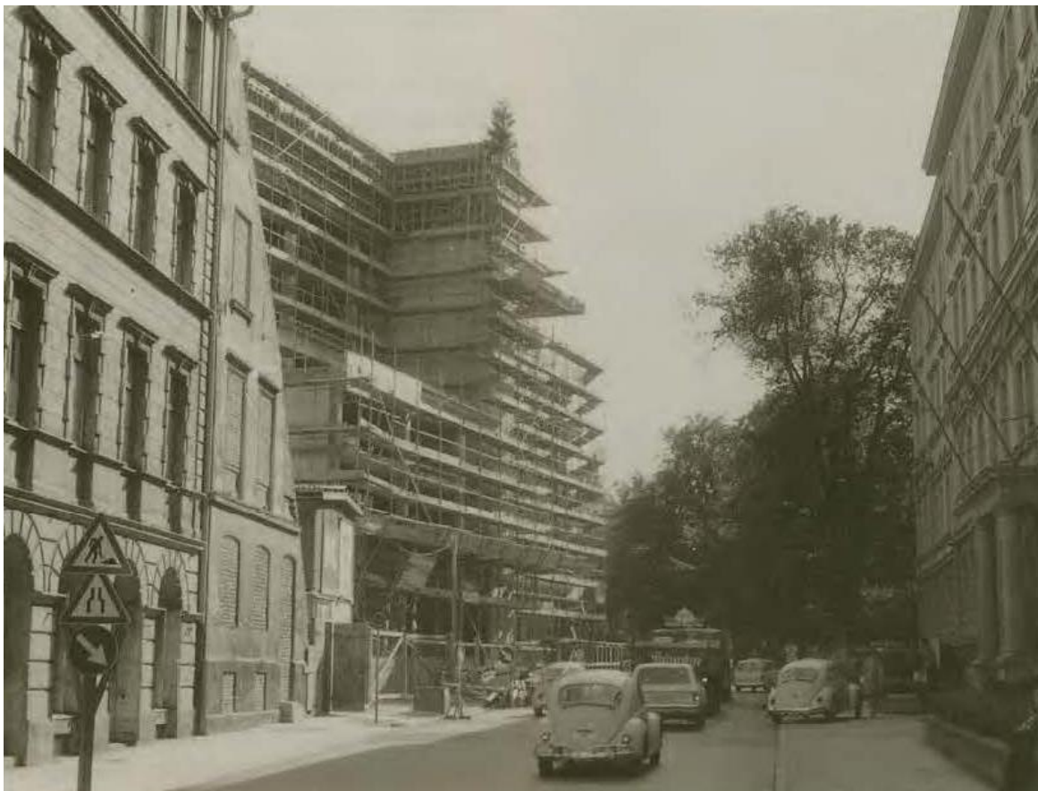
Quelle: Versicherungskammer Bayern: Richtfest für den 1. Bauabschnitt
